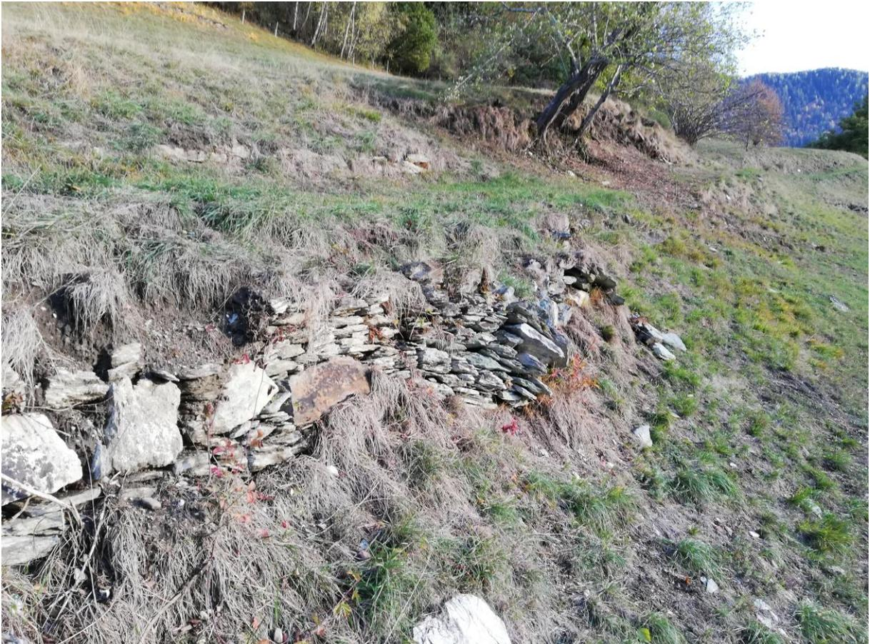
**Abschnitt 2:** typisches Schadensbild talseitige Stützmauer. Baum und Buschgruppe bergseitige Böschung
