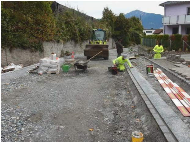
Strassensanierung Kurvenengnis Frassen mit neuem Gehweg rechts
