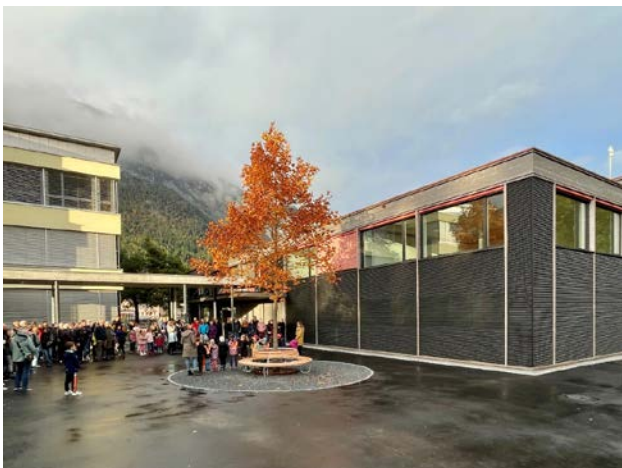
Besuchstag Fertigstellung Kinderhort und Turnhallenräume Cagails
