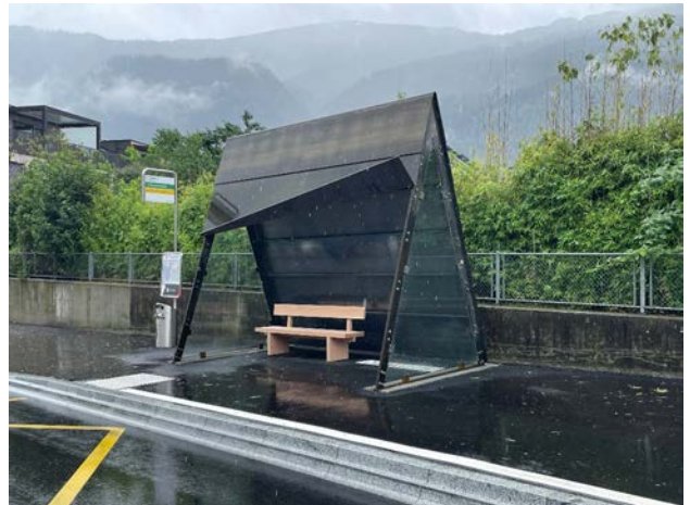
Sanierte Bushaltestelle mit hindernisfreier Einstiegs- und einheitlichem Emser Buswartehäuschen
