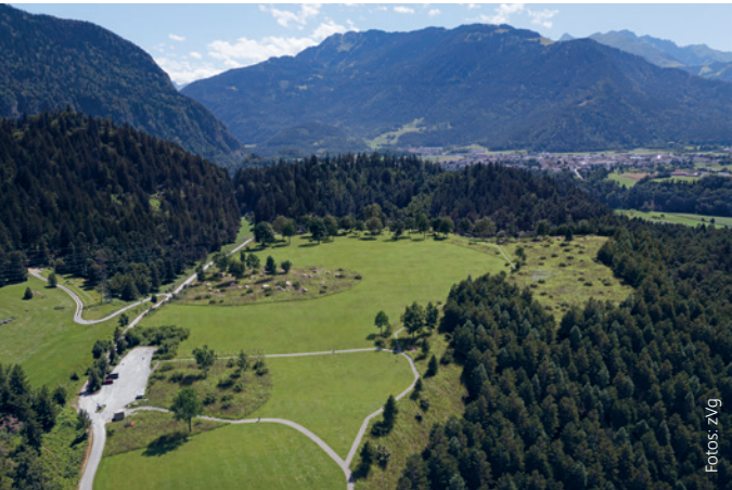
Plong Vasschnaus im Vergleich – dazwischen liegen rund 100 Jahre. Das obere Bild stammt aus dem Jahre 1961, vor dem Bau des Kieswerks Reichenau. Das untere Bild wurde etwa auf das Jahr 2070 visualisiert, nach Ende der geplanten Rekultivierung.
