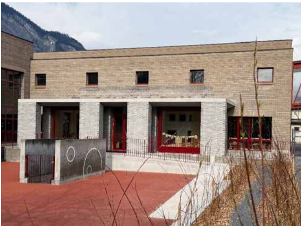
Kindergarten Tircal mit neuem Anbau – Spielplatzseite
