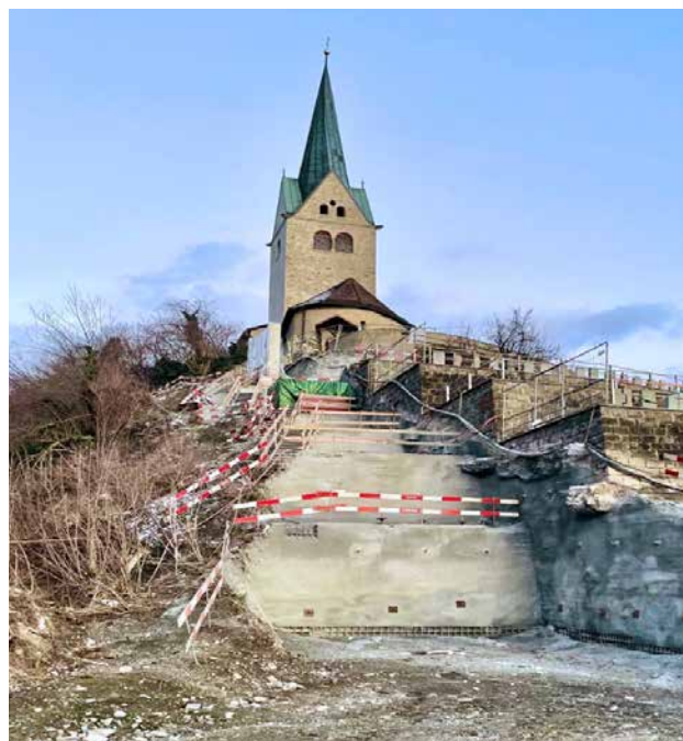
Hangsicherung und Fundamentarbeiten für das Schienentrassée des Schrägliftes
