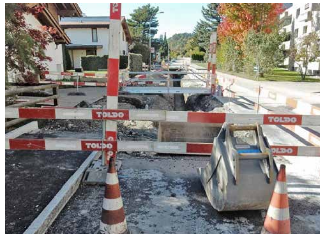
Jeweils halbseitige Strassen- und Leitungssanierung Via Calundis
