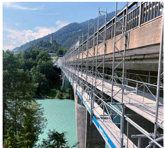
Rheinbrücke Tamins eingerüstet für die Montage der Trinkwasserleitung
