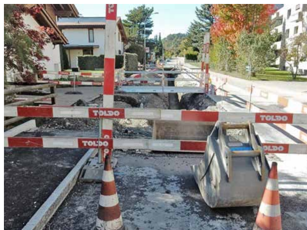
Jeweils halbseitige Strassen- und Leitungssanierung Via Calundis
