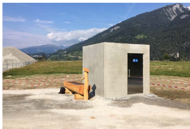
Familiengerechte und vandalensichere Toilette am Wiesen-, Kieswerk- und Parkplatzrand
