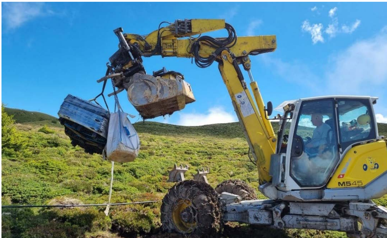
Bau der Viehtränken auf der Alp Urtgicla
